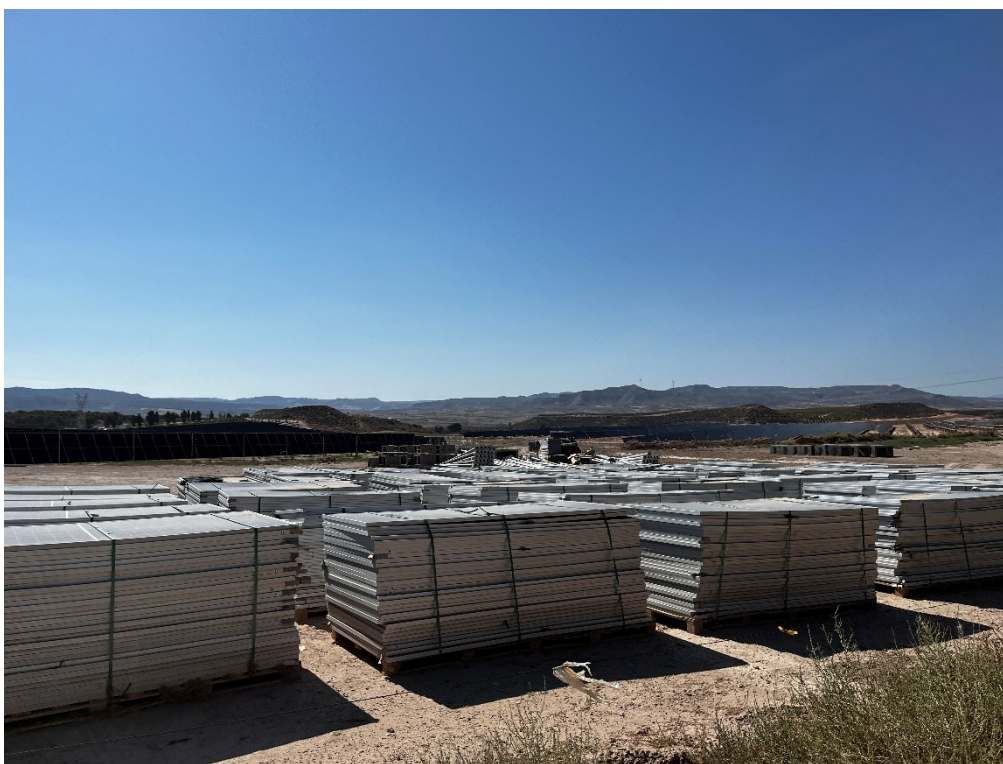
Figura 3 Acopio temporal de residuos no peligrosos
