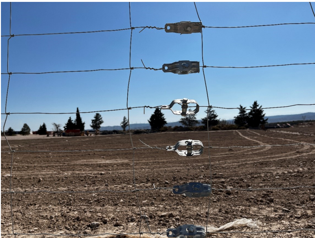
Figura 8 Elementos punzantes en el vallado perimetral
