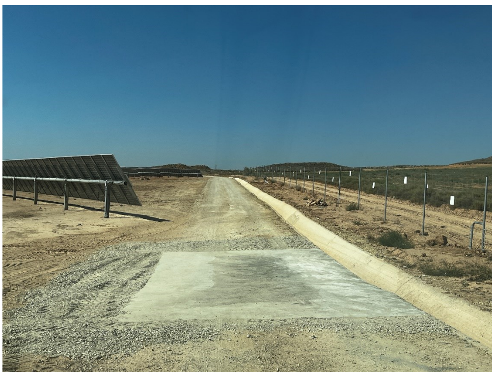
Figura 2 Cimentación del vial interno
